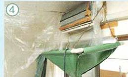
エアコン本体養生・キャッチャー取付
