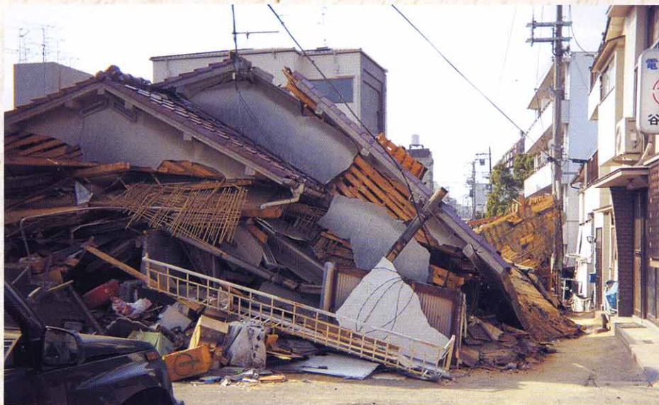
阪神淡路大震災で倒壊した木造住宅、倒れなかった右の建物との違いはなにか…。
