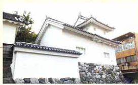
水をくみ上げるための井戸やぐら(乾櫓)
