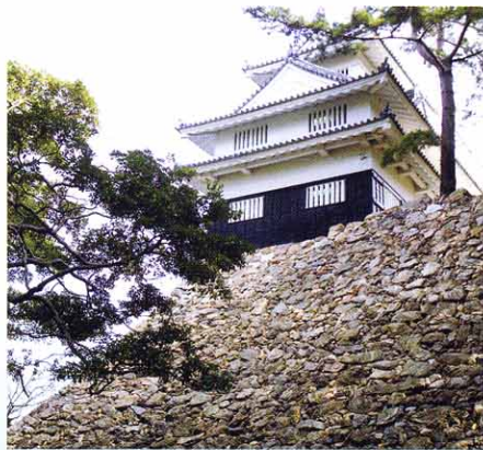
圧巻は400年の時を支える鉄櫓の石垣。江戸時代の改修で名古屋城に用意された石を転用したとも言われている。
