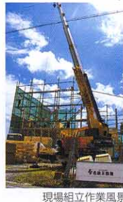
現場組立作業風景
