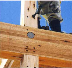
ピンの打ち込み作業
