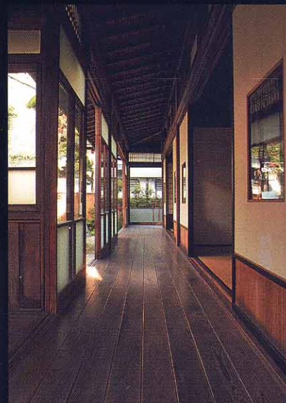
岩村城郭の払い下げのけやき材が使われたという離れの廊下。[勝川邸]
