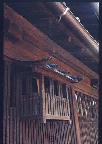
武者窓と呼び、藩主来邸の折に、見張りの窓となったと言われている。[木村邸]
