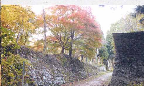
大手門跡 敵が攻めてくると橋板をとってしまう量橋があった。石垣も武者返しになっている。
