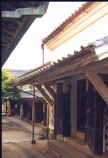
家財蔵。壁は、城の壁のように厚く盛られ、防火壁の役割も果たした。[勝川邸]
