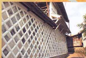
防火壁として利用されたなまこ壁
