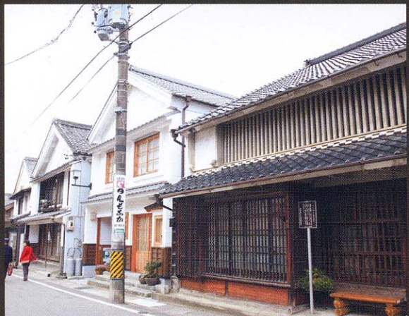
本町に残る旧造酒屋の建物を再利用した家並み。
