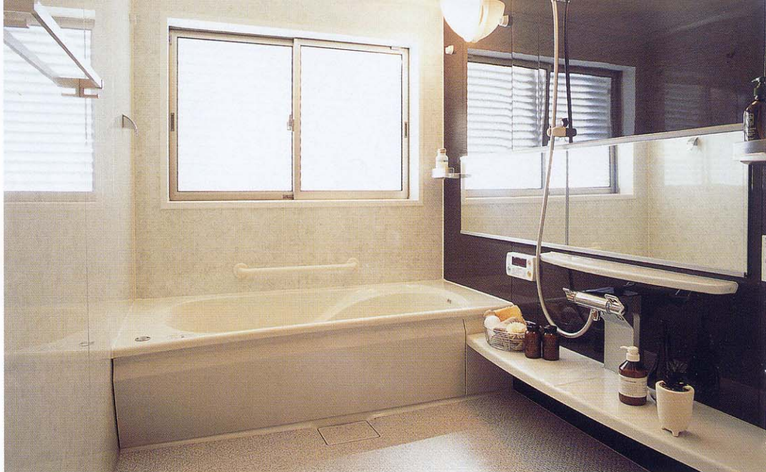
浴槽の高さ、手摺り、滑りにくい床など、ユニバーサルデザインが図られている浴室の例。(名鉄ホーム「わが家」より)
