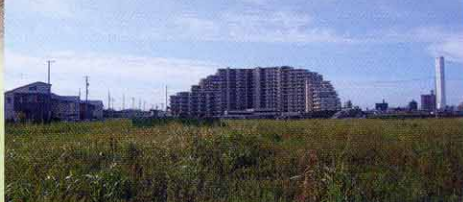
①グリーン・スパーク稲沢21 写真中央の「エムシティ稲沢」をはじめ、公園や商業施設などの建設整備が進む、旧国鉄の操車場跡地を含むJR稲沢駅の東側約63haの大規模開発。
