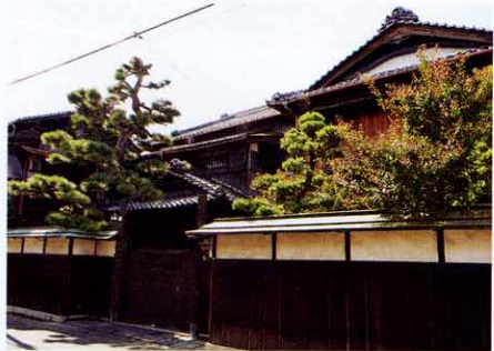
堀田家住宅(国の重要文化財) 江戸時代中期、正徳年間(1711~1716)建造。県道拡幅工事のため、昭和48年に約60m西の現在地に移転した。平成8年3月から市の所有。敷地面積は、623坪(2,055㎡)。質も、保存状態も良く、屋敷の構えや間取りなどには尾張の地方色がよく現れている。住宅は、主屋と3棟の土蔵から構成されている。桁行7間半、梁間7間、切妻造重層様瓦葺の主屋は、江戸時代の町屋独特のもの。3棟の土蔵は、屋敷の玄関から主屋の座敷部分を通り抜け奥の蔵に達するように、建物の北方に並んで配置。これは、尾張の町屋建築の特徴と言われている。(堀田家住宅の案内書より引用)
