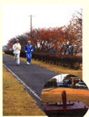
水路に蓋をした箇所の一部は遊歩道・自転車道として整備されている。
