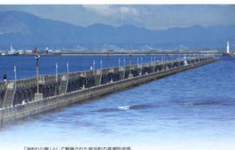
「海釣り公園」として整備された南浜の高級防波堤。
