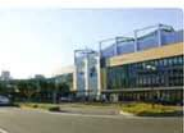
快適になった岡崎の玄関、名鉄本線「東岡崎」駅南口
