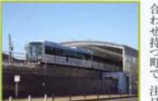
はなみずき通駅(リニモ) リニモ「万博博覧会時に国内初の磁気浮上式鉄道路線として実用化される予定の建設中の駅舎」
