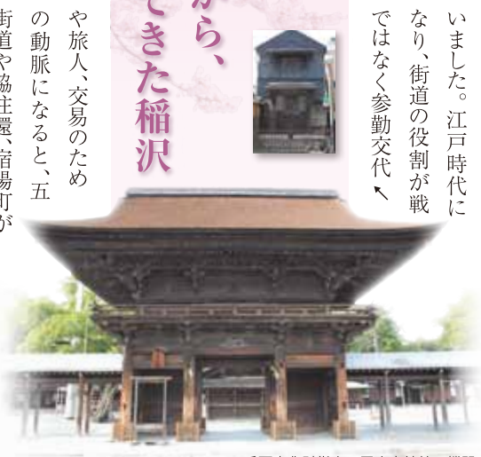
重要文化財指定の国府宮神社の楼門
