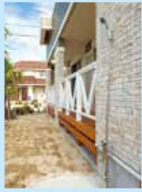
屋外シャワーを全戸に設置
