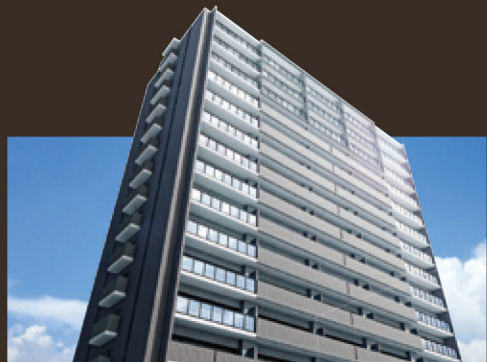
外観完成予想図 ※掲載のCGは計画段階の図面を基に描き起こしたもので、実際とは異なります。
