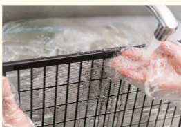
浴室暖房乾燥機は換気扇を分 解、ファンやカバー、フィルタ ーを洗浄。内部まで徹底的にきれ いにします。
