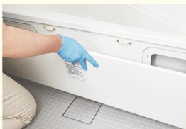
浴槽のエプロン内部は汚れが いっぱい。カバーを取り、スポン ジとブラシを使い、カビ取り洗剤 で汚れを取ります。
