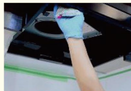
レンジフードまわりを養生し、 パーツを外したら本体内部を丁 寧に清掃。油汚れ用洗剤とブラ シを使います。
